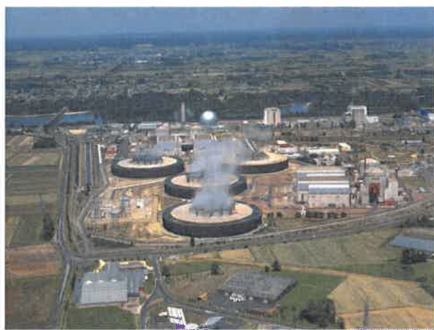
Illustration 1: Centrale Nucléaire de Chinon (Source EDF)
