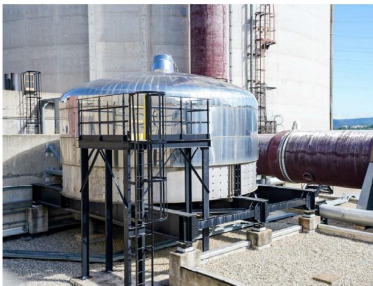
Figure 15. Photo du dispositif d'éventage et de filtration de l'enceinte (filtre U5)
