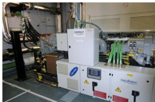
Nouveau groupe froid (+ 50% de capacité frigorifique)
